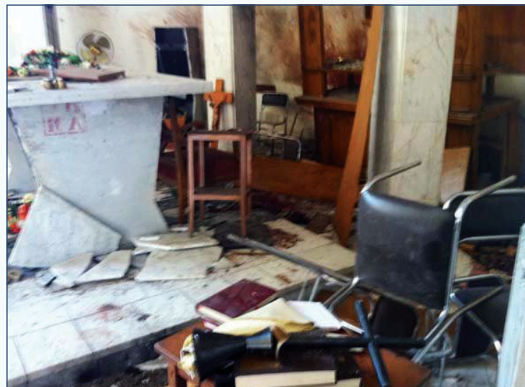
Der völlig zerstörte Altarraum
